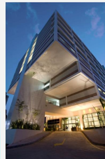
Entrada da internação e alta
