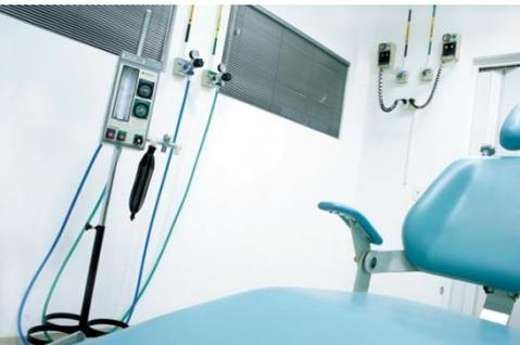
As instalações de gases medicinais para os serviços odontológicos devem ser executadas conforme as recomendações da RDC/Anvisa n.º 50, de 21 de fevereiro de 2002, e da norma ABNT NBR 12.188 – Sistemas centralizados de oxigênio, ar comprimido, óxido nitroso e vácuo para uso medicinal em estabelecimentos de saúde.
