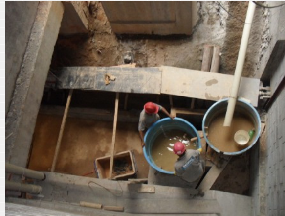
Limpeza Caixa de decantação
