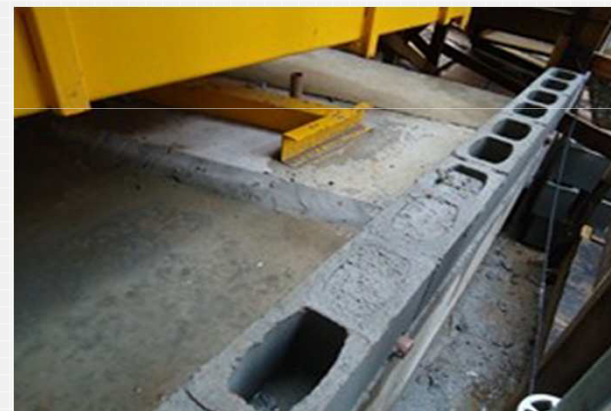
Mureta Contenção Base Gremalheira
