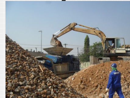
Entulho de demolição Britado
