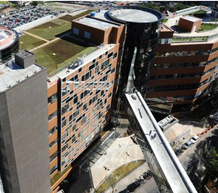
Hosp. Albert Einstein Morumbi São Paulo - SP LEED NC2.2 Gold - Agosto/2010
