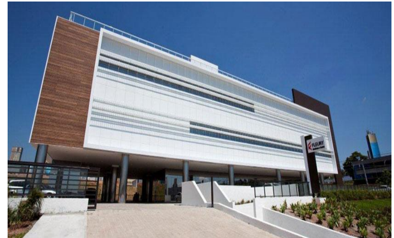
Unidade Fleury - Alphaville Barueri – SP LEED NC3.0 Gold – Novembro/2012
